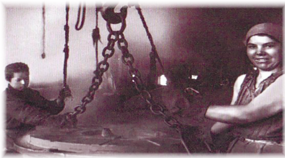
Цех № 8. Разгрузка котла
