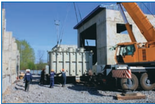
Строительство подстанции «Искра», г. Череповец. Фото с сайта www.elec.ru
